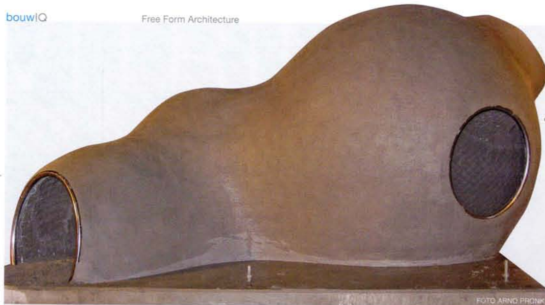
Ballonnen met kabelnetten als mal. Na het aanbrengen van het spuitbeton ontstaat de blob.
